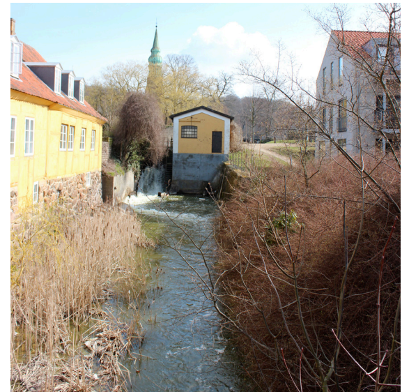
C - Slusen ved kanalen
