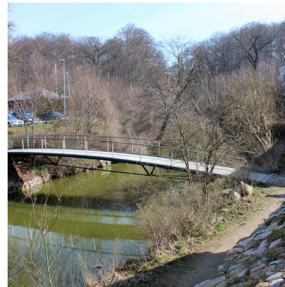
B - Gangbro over kanalen
