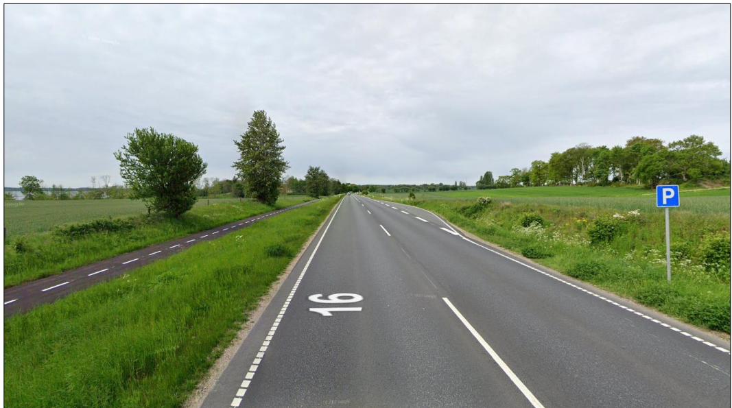
Figur 5. Amtsvejen (rute 16) ca. 1 km. vest for Hanehoved klassificeret som 'Trafikvej, gennemfartsvej' (Kilde: Google Maps, maj 2021).
