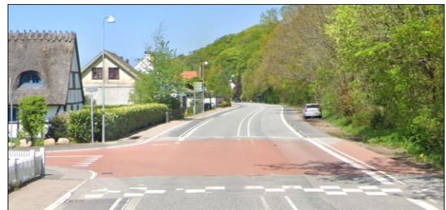
Figur 18. Tosporet 40-km/t cirkelbump på Helsingvej (rute 205) i Vinderød (tv.) og hævet flade på Vinderød Skov i Frederiksværk (th.) (Kilde: Google Maps, maj 2021).
