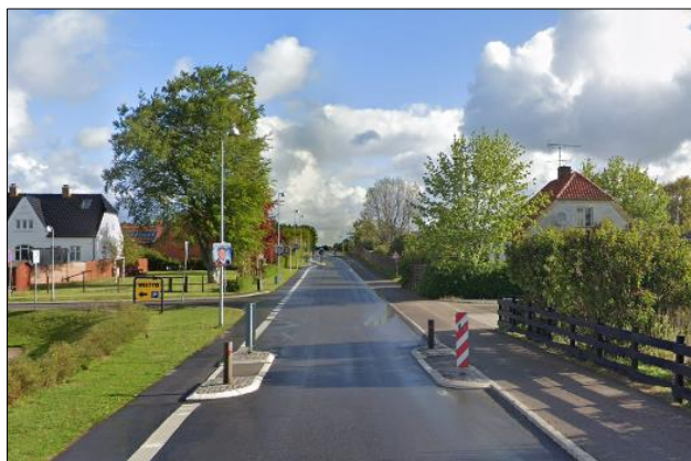
Figur 19. To eksempler på indsnævring til ét spor fra hhv. Hovedgaden (tv.) og Byvej (th.) i Ølsted. (Kilde: Google Maps, juni 2021).
