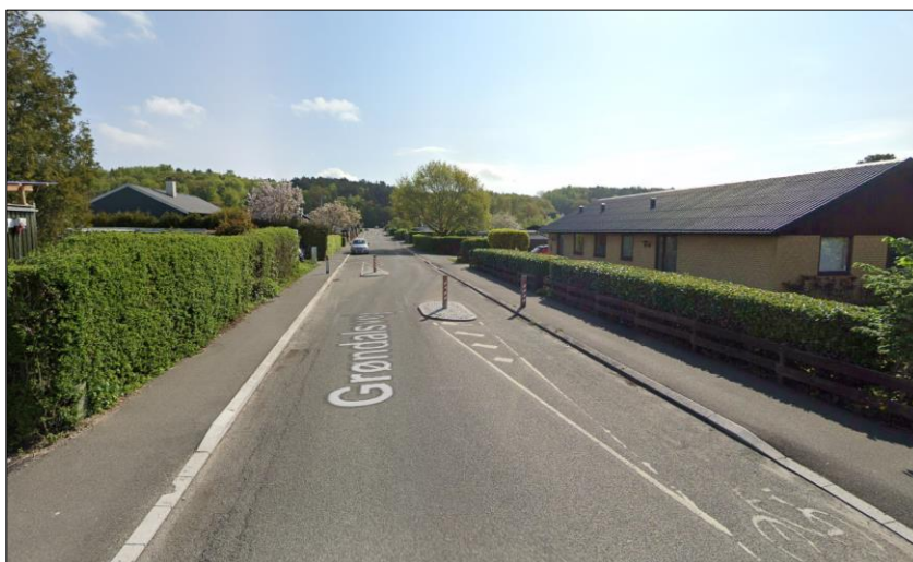
Figur 20. Forsætning med indsnævring til ét spor og cykelsluser på Grøndalsvej i Frederiksværk. (Kilde: Google Maps, maj 2021).
