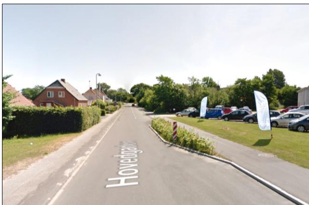
Figur 19. To eksempler på indsnævring til ét spor fra hhv. Hovedgaden (tv.) og Byvej (th.) i Ølsted. (Kilde: Google Maps, juni 2021).
