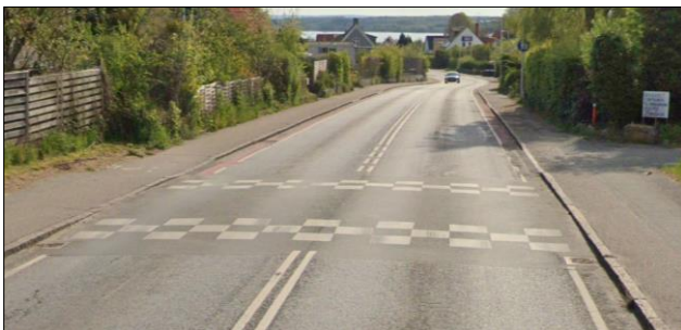
Figur 18. Tosporet 40-km/t cirkelbump på Helsingvej (rute 205) i Vinderød (tv.) og hævet flade på Vinderød Skov i Frederiksværk (th.) (Kilde: Google Maps, maj 2021).
